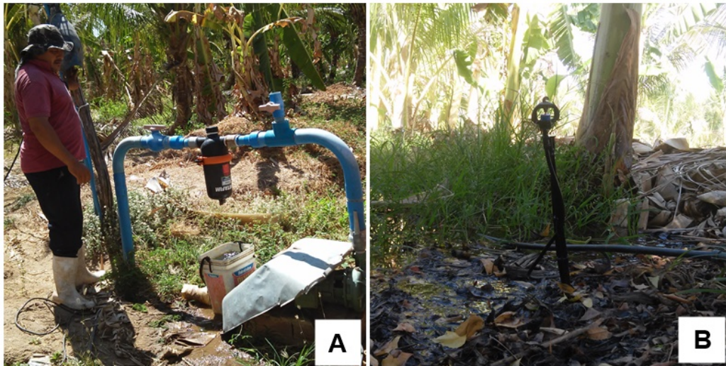
Figura 4. Sistema de microaspersão utilizado no PIVAS. (A) Filtro em um lote do setor 06. (B) Tubulação e microaspersor em um lote do setor 04.
